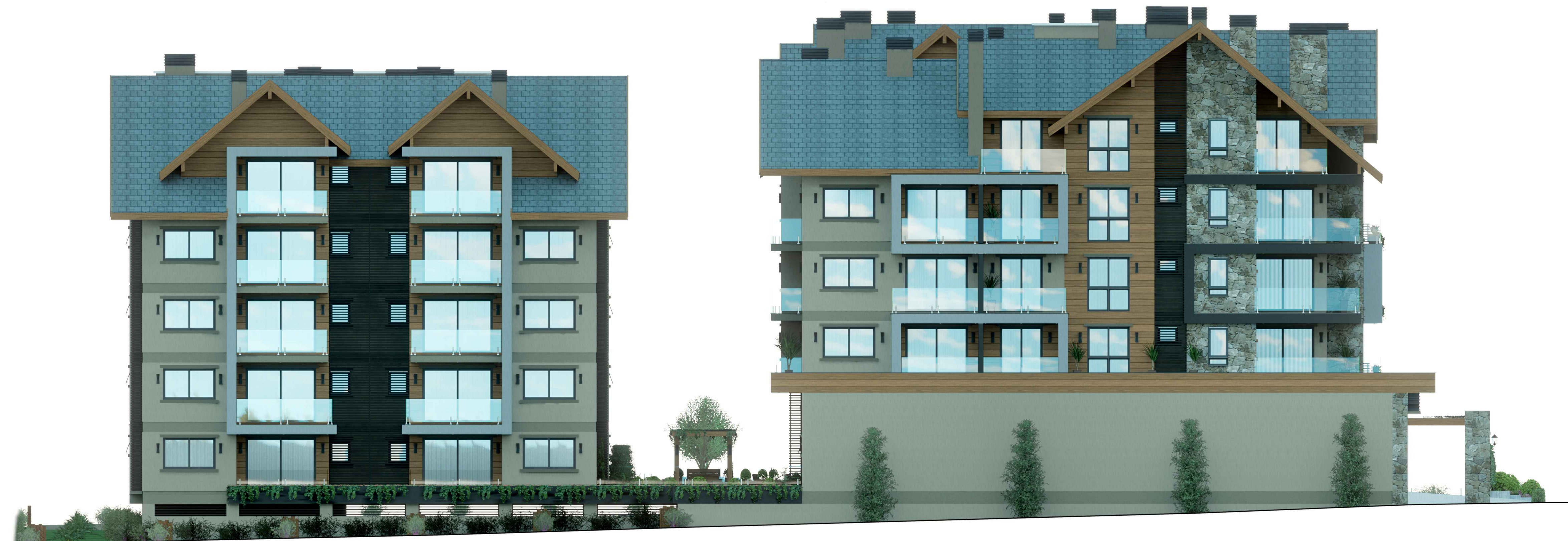
Fachada Lateral Esquerda
